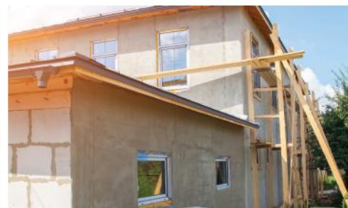
Renovuojant namų sutappimas dar didesnis. Modernizuotas pastatas šilumos sąnaudas sumažina net 30-50 proc.
